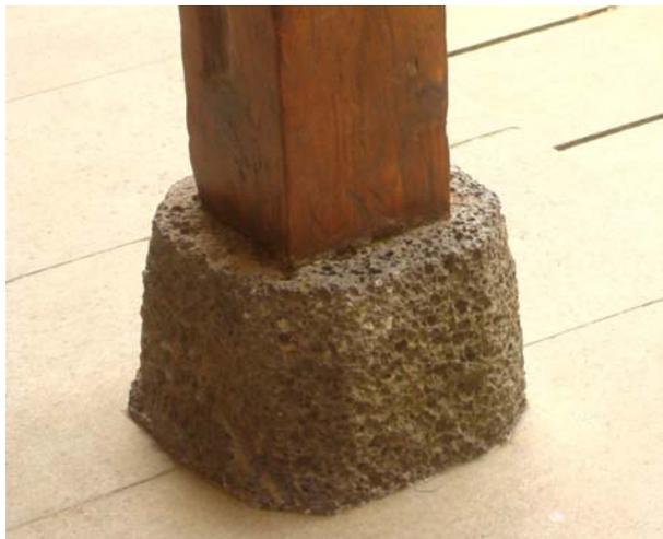
Fig. 4.10. Base de columna fabricada en toba. La Laguna
