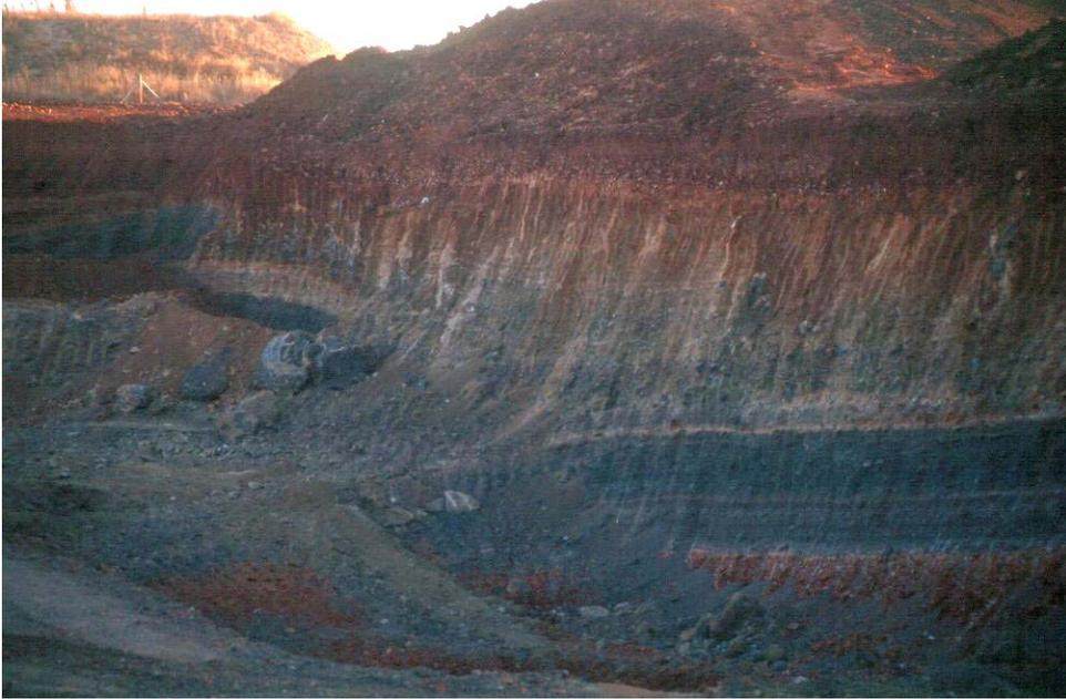
Figura. 5.30. Explotación intensiva para la extracción de zahorra. Canteras abiertas al sur de Ciudad Real con motivo de las obras de la autovía Ciudad Real-Puertollano
