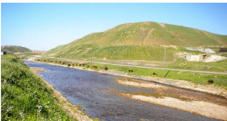
Figura 51. Escombrera y desvío del trazado fluvial por ocupación del dominio hidráulico del Ojailén
