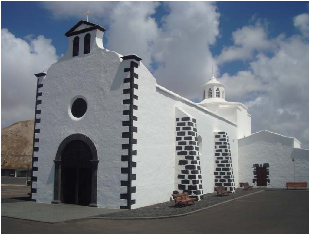
Figura 2. Edificio religioso en el que se emplean sillares de basalto en esquinas, contrafuertes, portadas y espadaña, combinado armoniosamente con el encalado de los muros
