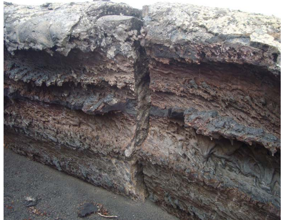
Figura 9 c, Grietas de asiento.
