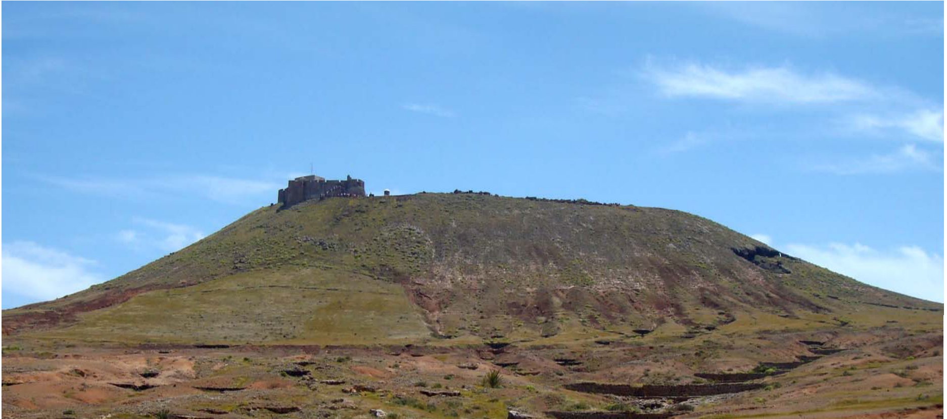
Castillo de Santa Bárbara edificado sobre un cono volcánico que domina los llanos de Teguise
